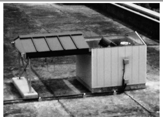
図 1：慶應義塾高等学校屋上に設置されたインターネット天文台一号機。アストロ光学製スライディングルーフ観測室を採用。
