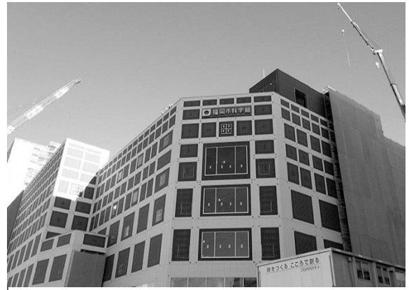
(図2) 建設中の福岡市科学館
