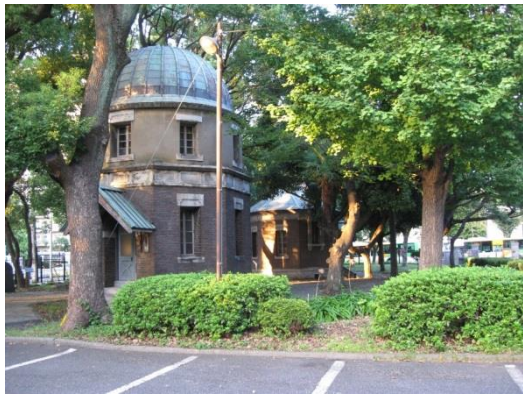
図4 天文遺産対象事物の一例。現存最古の天文台建物。1903年(明治36年)建築。東京海洋大学構内(越中島キャンパス)、登録有形文化財。
