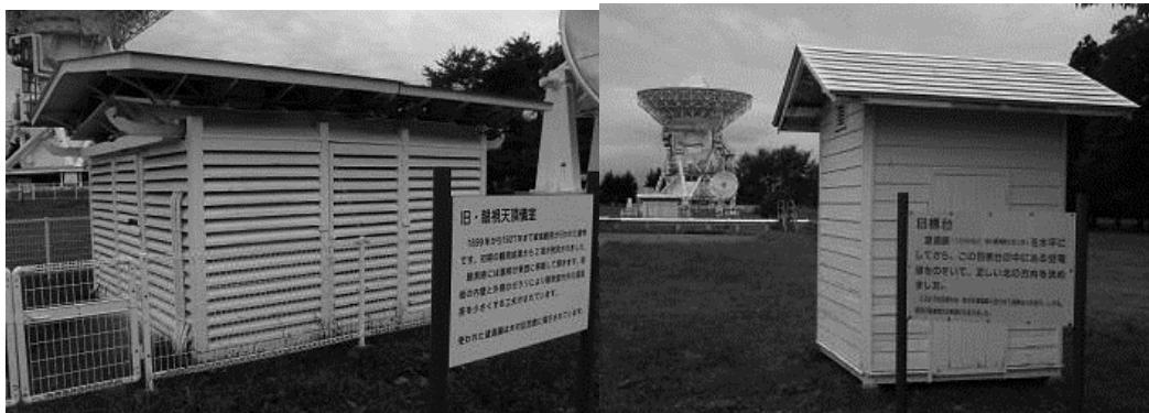
図2 眼視天頂儀室（左）と目標台（右：遠くに見える眼視天頂儀室の真北に設置されている）
