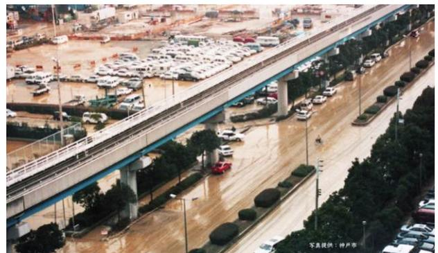
図 17 ポートアイランドの震災による液状化[28]
