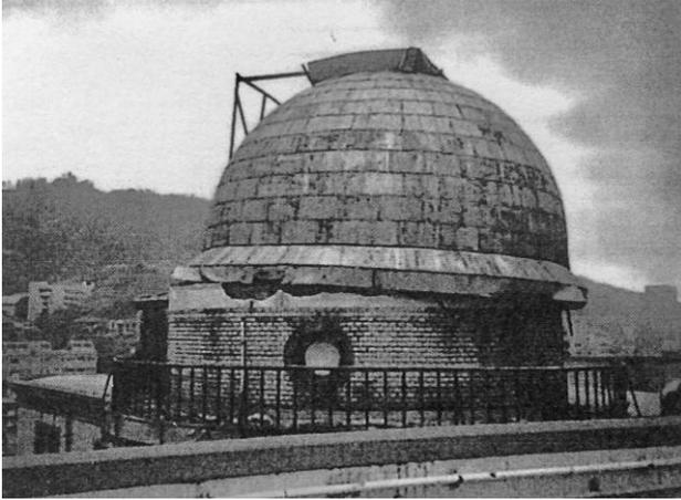
図 18 震災により破損した神戸海洋気象台天体観測室ドーム[3]
