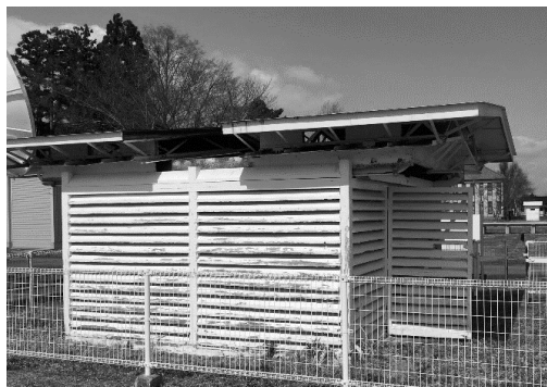
図 4 旧眼視天頂儀室。右奥に小さく目標塔及び覆い屋も見える。
