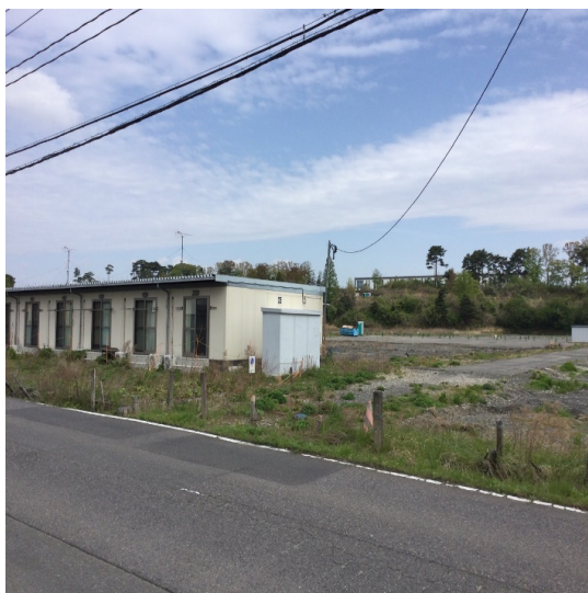
図1 県内最大級の624戸の仮設住宅があった場所も、現在は1棟（無人）を残して解体されました（郡山市内 若宮前応急仮設住宅）
