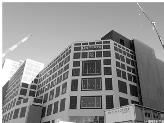
図 2 建設中の福岡市科学館
