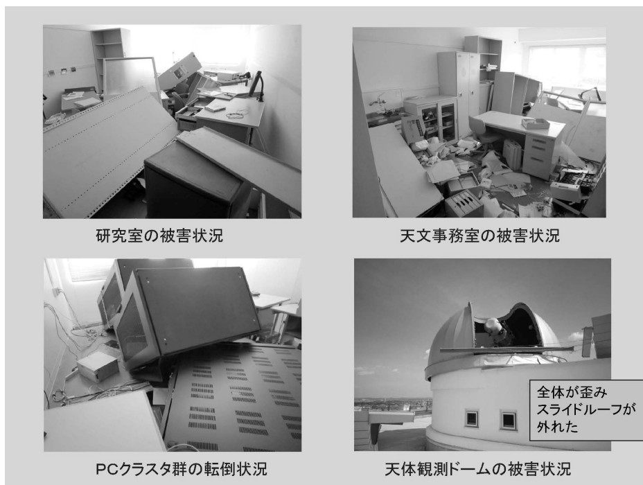
図1 東北大における被災状況
