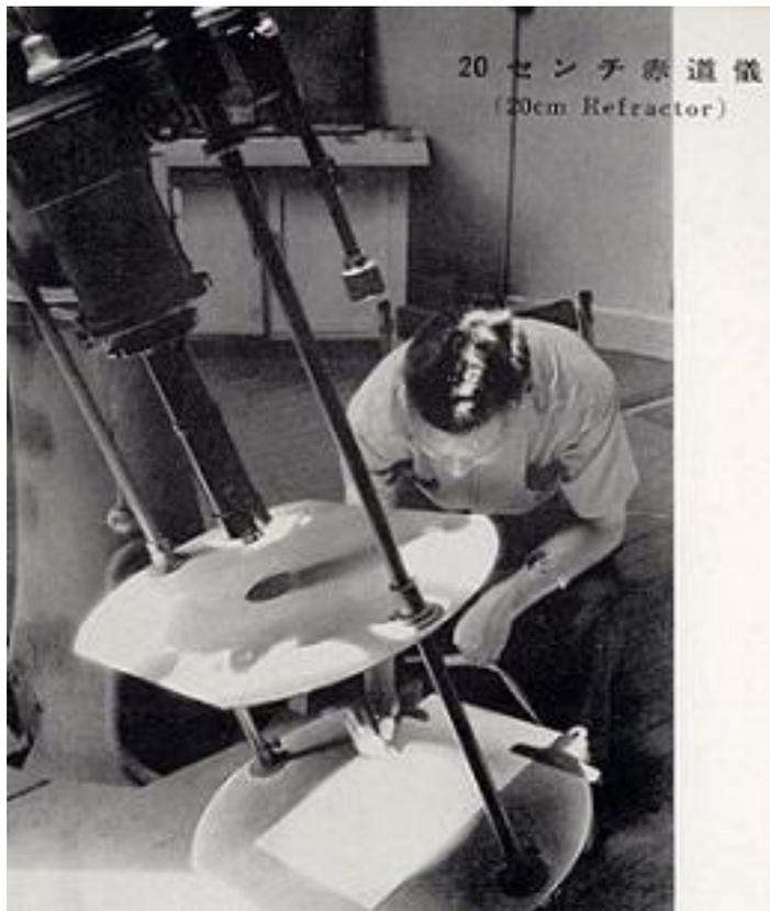
直径 20 cm, 焦点距離 359 cm の対物レンズを使った屈折望遠鏡で、ドイツ製です。
