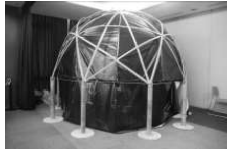
写真③ 完成した竹ドーム(改良形)
