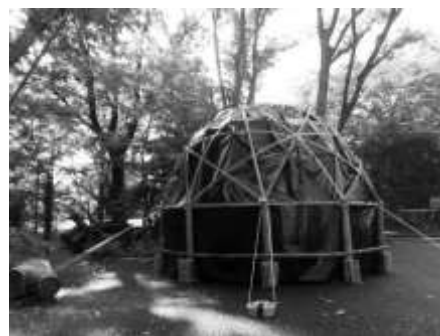
写真② 完成した竹ドーム(初期形)
