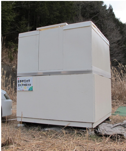
図7 完成した1.8 m天文ドーム
