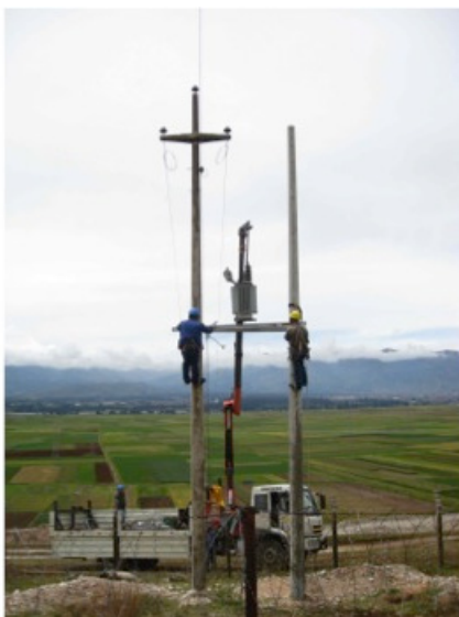
図6 2012年3月20日、変圧器が設置される歴史的な瞬間
