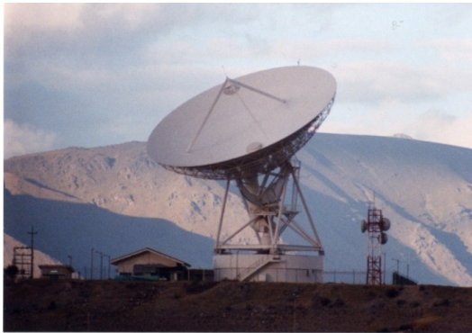
図 1 衛星通信に使われていたシカヤの直径 32m のアンテナ
