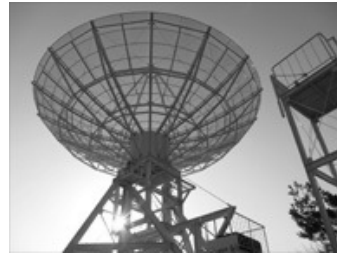
図2 直径12mパラボラアンテナを持つ電波望遠鏡
