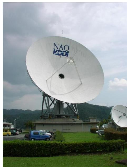
図4 山口大学32mアンテナ。さざんか計画に参加した電波望遠鏡では最大のもの。
