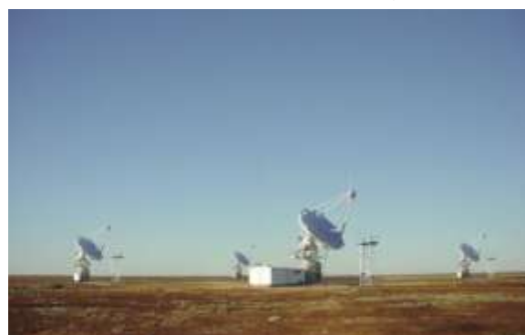
図 9 カンガルー望遠鏡。大気チェレンコフ光を観測することでガンマ線を捉える。甲南大学の web ページ ( http://www.hep.konan-u.ac.jp/pukiwiki/index.php?CANGAROO ) より。
