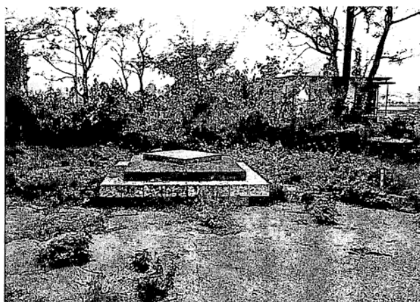
図12 那須基線南端点（大田原市）。石材で覆われた中に南端点がある。写真右端に白い小杭が見えるが、そこに三角点がある。基線は写真右方向に向かって延びている。
